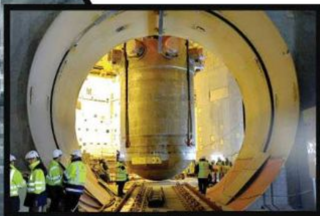
^ Début 2014, les équipes d'EDF, visiblement mal informées, soudent la cuve défectueuse à l'intérieur du réacteur.
