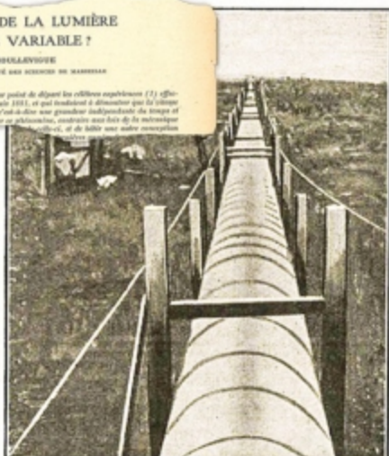
FIG. 6. — VOICI LE TUBE À VIDE DE UN MILLE DE LONG (1.000 MÈTRES), QUI A SERVI AUX DERNIÈRES EXPÉRIENCES DE MICHELSON ET DE SES SUCCEPTEURS
