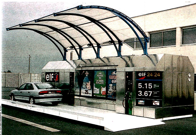
Entièrement démontable, transportable par la route, la nouvelle station-service Elf fonctionne exactement comme une pompe fixe classique.
