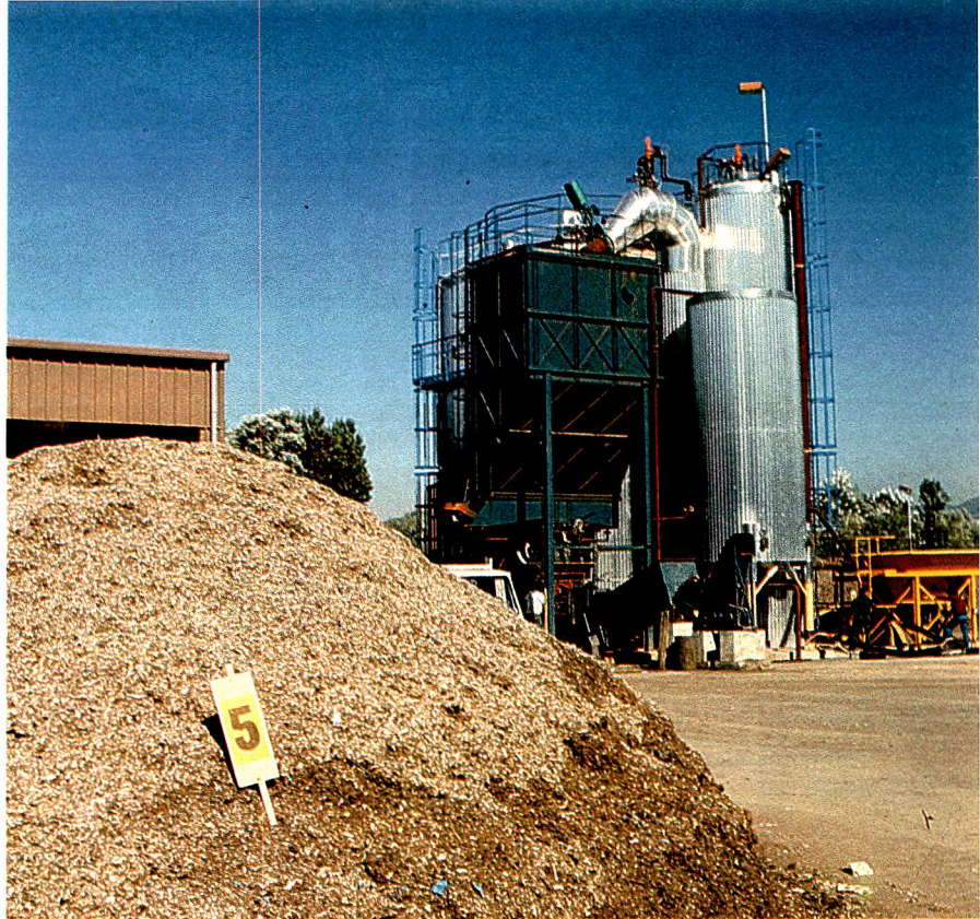
La méthanisation. Après broyage et tri, les éléments organiques des ordures sont mis à fermenter pendant une quinzaine de jours dans un digesteur, cuve maintenue à 37 °C environ (au second plan sur la photo). Il en résulte du gaz (méthane essentiellement), revendu à Gaz de France, et un digestat proche du compost et intéressant les mêmes usagers (au premier plan).
