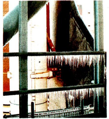
La glace sur la rampe de lancement. Inhabituel en Floride. Au décollage, la glace a été enlevée. Mais des températures anormalement basses avaient été relevées sur la paroi du booster droit.
