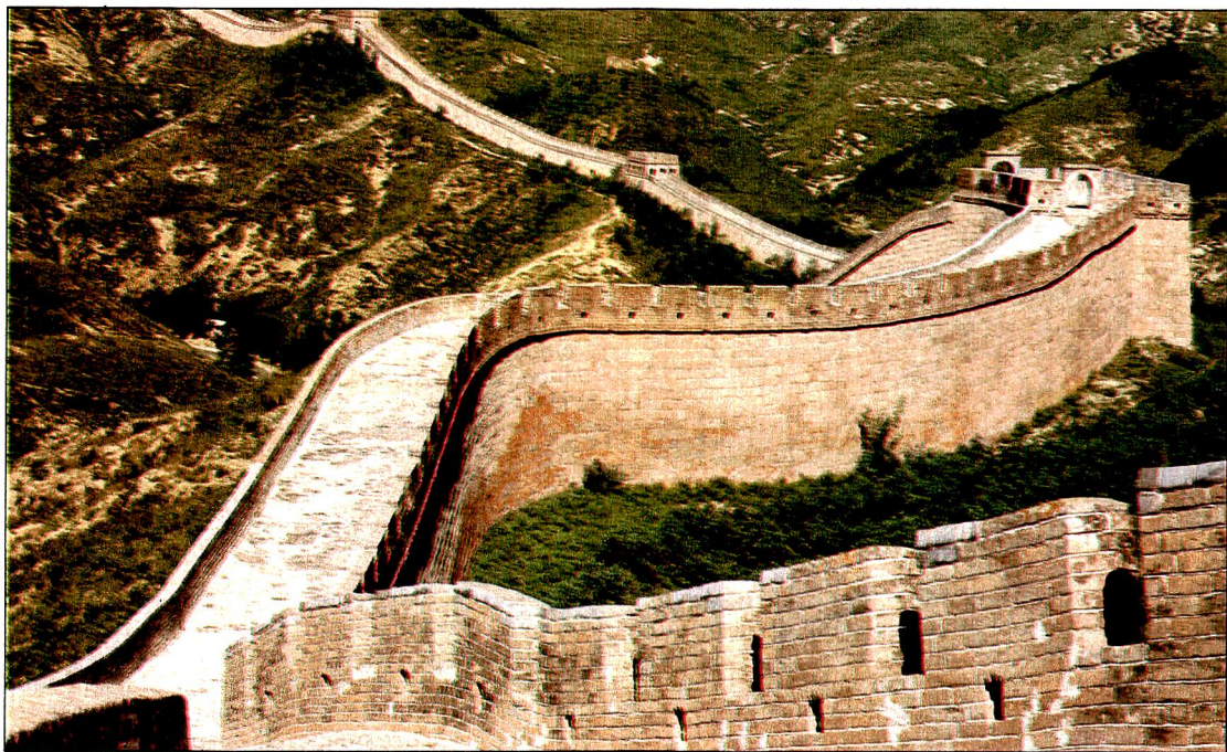
Comme toute construction en brique crue traditionnelle, la Grande Muraille de Chine ne survit qu'au prix d'un entretien permanent.
