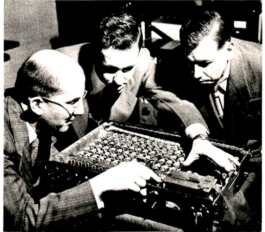
Exemple de technologie typique de la fin des années 1940 sur le petit calculateur expérimental d'Edmund C. Berkeley. On distingue le lecteur de bande perforées et les relais composant l'Unité Arithmétique et Logique de la machine.
